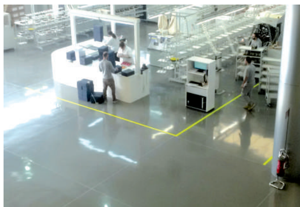
Realizzazione di una pavimentazione autolivellante e giunti a vista con Res Flexible. Installation of a self-leveling floor with visible control joints using Res Flexible.
