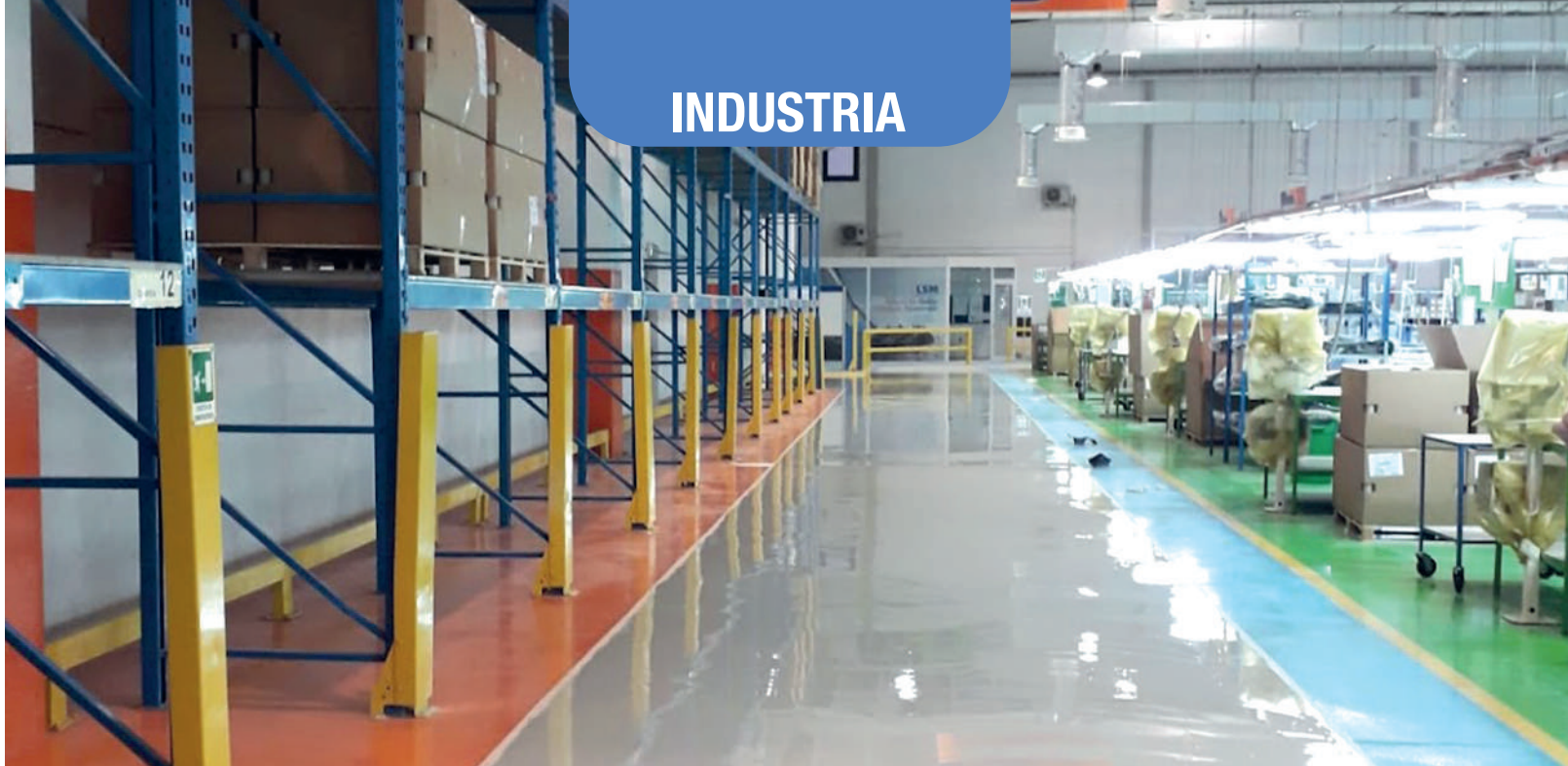
Autolivellante epossidico con realizzazione di segnaletica orizzontale presso industria di componenti automobilistici. Self-leveling epoxy with the creation of horizontal signage at an automotive component manufacturing facility.
