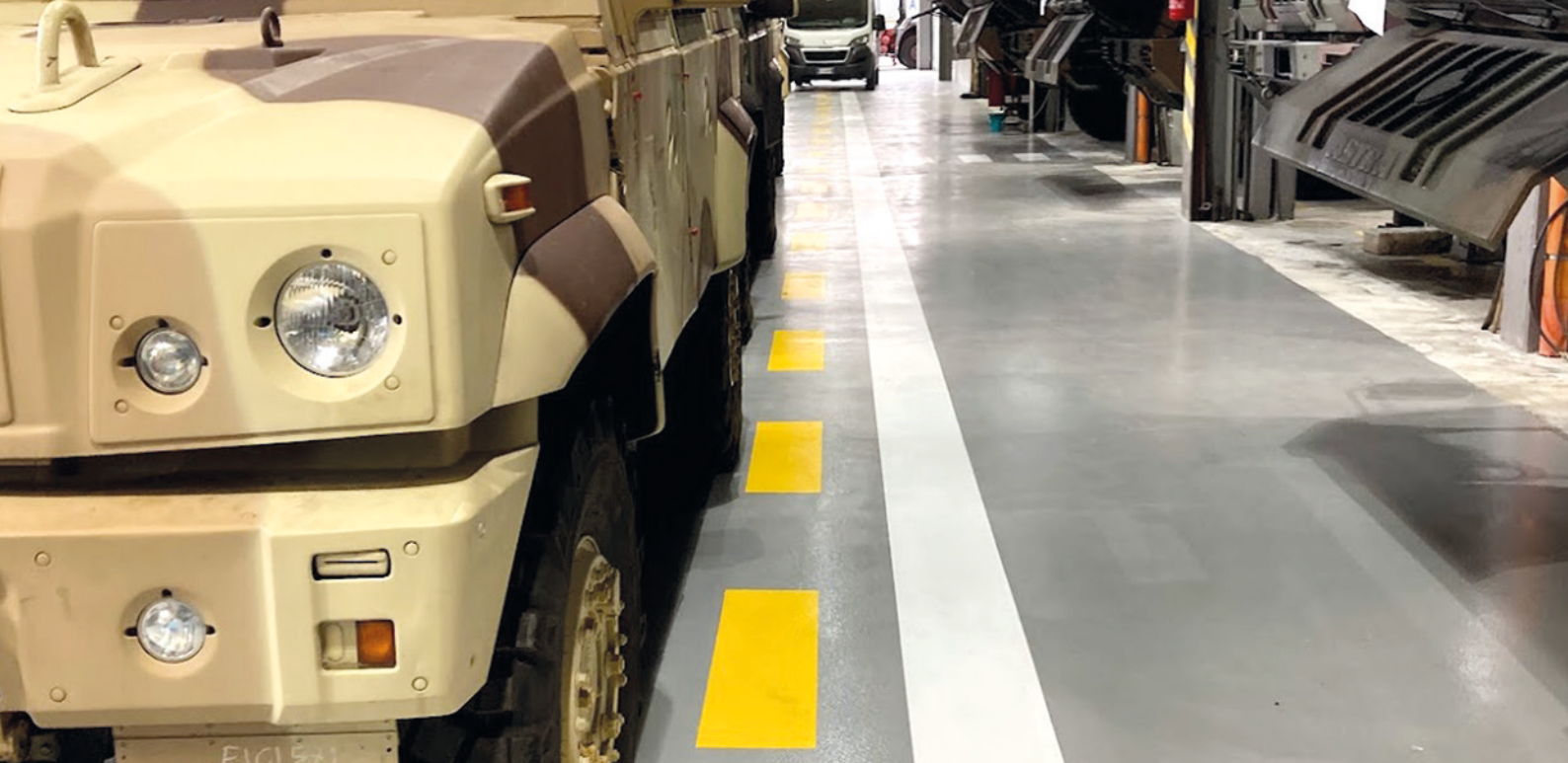
Sistema multistrato 4S e segnaletica orizzontale con Res Vernice Epossidica in un'officina militare.
