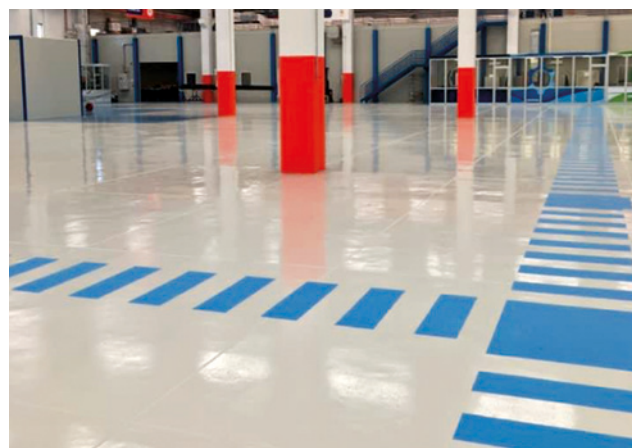
Realizzazione di segnaletica orizzontale su autolivellante Res Level in un'industria meccanica.
