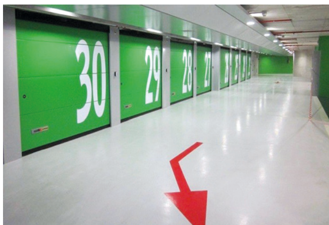
Sistema multistrato S con realizzazione di segnaletica orizzontale in un parcheggio.
